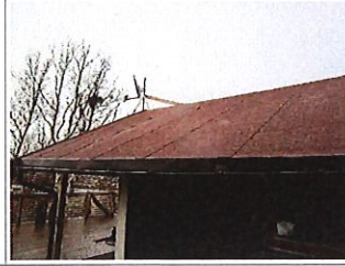
Heng og vannoppsamling renne tilbygg.
