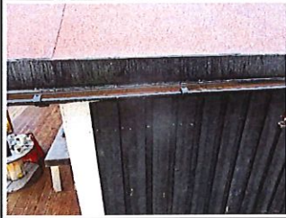
Heng og vannoppsamling renne tilbygg.
