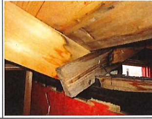
Vanninntrenging som følge av utett yttertak.
