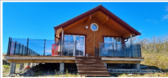
Fasade mot øst/utsikten.
