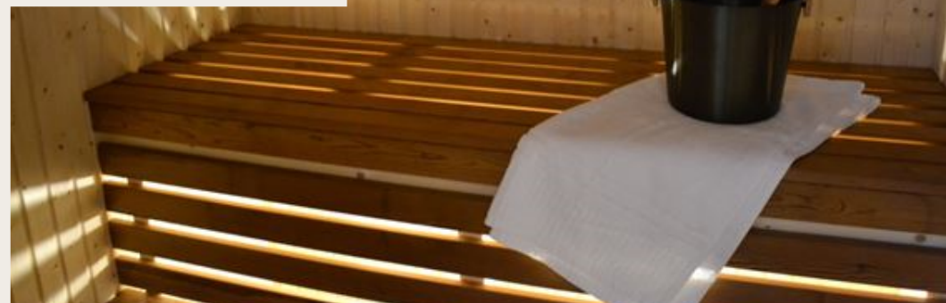
Vegg og tak Gran 12x070 faspanel, ubehandlet
