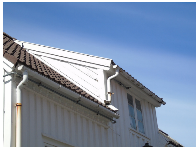
Eksempel på Stavangerark. Her med taknedløp på neste takflate. Noe som ikke er vanlig og som vanligvis ikke tillates. Foto: Solveig Roti Dahl, RFK.
