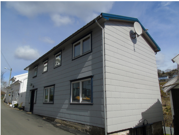
Det er ikke riktig å tilbakeføre hus som både har endret form og materialbruk. Foto: Solveig Roti Dahl, RFK.
