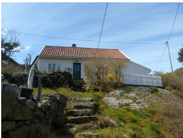
Trapp i naturstein, her vil det være vanlig vedlikehold å legge på plass stein som har glidd ut av posisjon. Foto: Solveig Roti Dahl, RFK.
