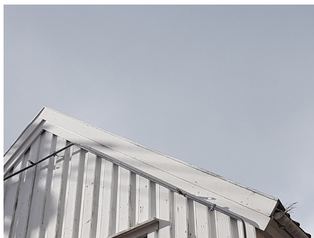
Eksempel på vindskier og vannbord som går over takpanner. Foto: Solveig Roti Dahl, RFK.
