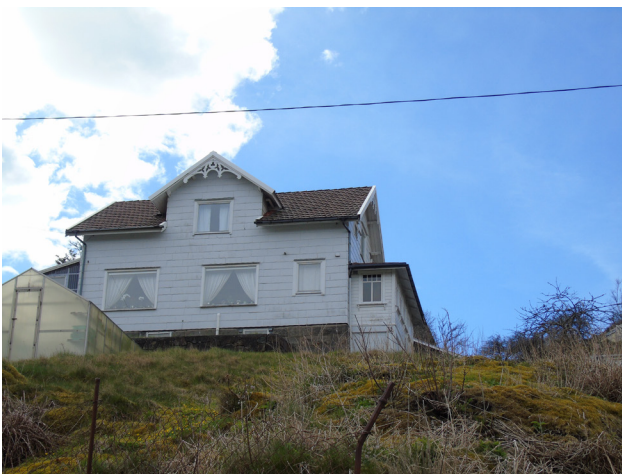
Hovedformen og noen viktige detaljer er intakt. Tilbakeføring av vindustype og kledning bør kunne tillates ved dispensasjon. Foto: Solveig Roti Dahl, RFK.
