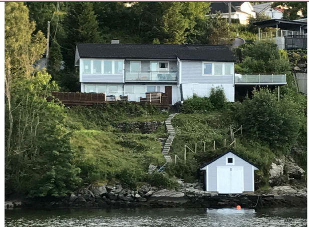
Fasade fra vannet.
