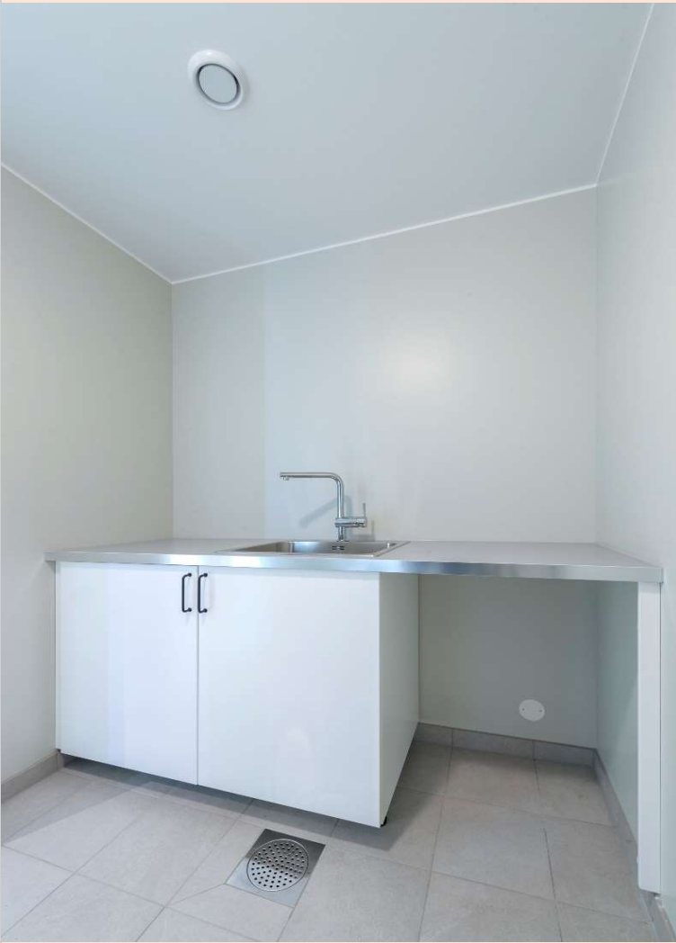
Vaskerom inneholder teknisk skap, vaskeromsinnredning, opplegg for vaskemaskin, og sluk i gulv.
