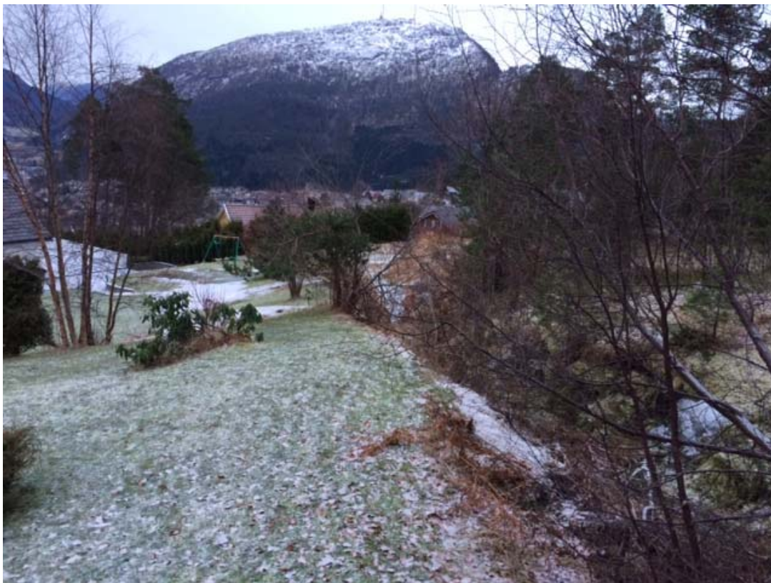
Biletet over viser dreneringsgrøft i overkant av både g/bnr. 62/828 og 62/830, sett i retning Hafstadjellet.
