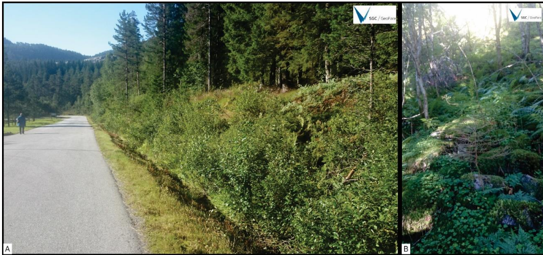
Figur 21: A: Langs vegen heile bilvegen er det ei grøft. B: Gamal ur ovanfor vegen.
