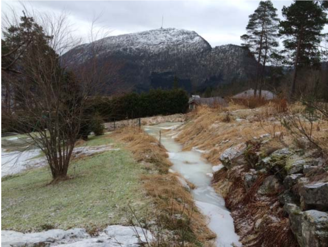
Biletet over viser dreneringsgrøft i overkant eigedom 62/830, sett i retning Hafstadjellet.
