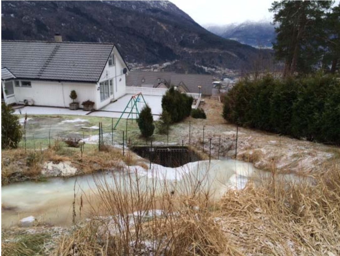
Bileta over og under viser nedløp til dreneringsgrøft, plassert mellom g/bnr. 62/830 og 62/832. Nedløpskum ligg inn mot tomtgrensa til eigedom 62/830.
