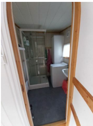
Bad Dusjkabinett, varmtvannbereder, vaskemaskin og servant. Hovedvanninntak på bad med varmekabel innlagt i vannledning inn til hytte.
