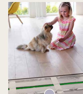
Varmegulv Til oppholdsrom
