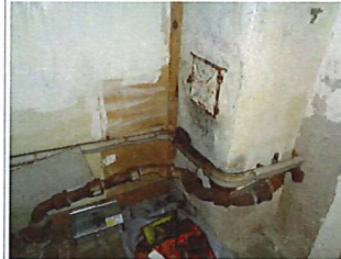
Rør i bakkjeller.
