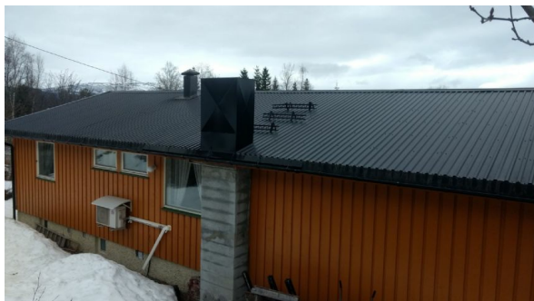
Grunnmur, kledning, pipe og yttertak
