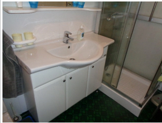
Servantskap i bad.
