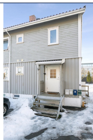
Felles inngangsparti fra parkeringen
