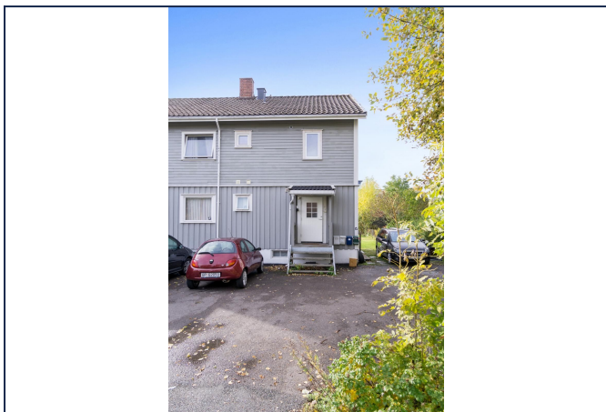
Parkeringsplass og inngangsparti (sommerbilde)
