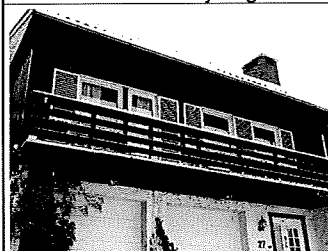
Terrasse/balkong på adkomstfasaden med adkomst fra soverom
