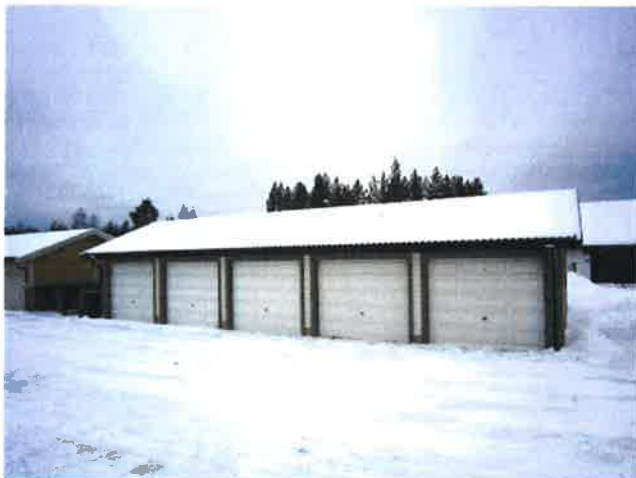
Garasjerekke: (Bilde fra 09.03. 2012).
