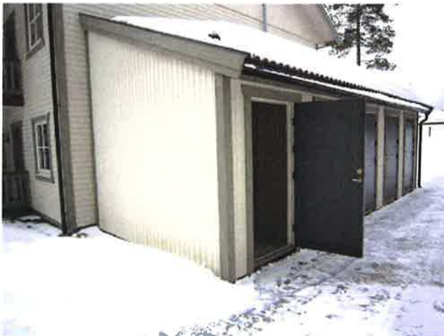
Utvendig bod: (Bilde fra 09.03. 2012).
