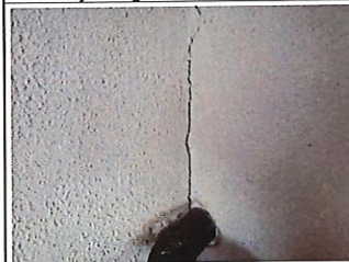
Brudd i pipe.
