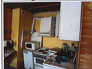
Kjøkkenen underetasje. Totalskadet.
