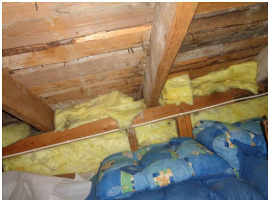
Kott i 2. etasje
