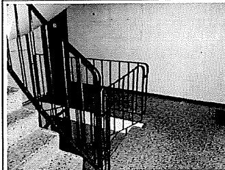
Trappoppgang med betong trapp og terrassobelegg i toppsjiktet med malt metall rekkverk
