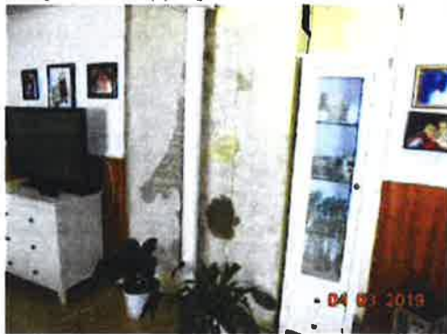
Murverk i stue
