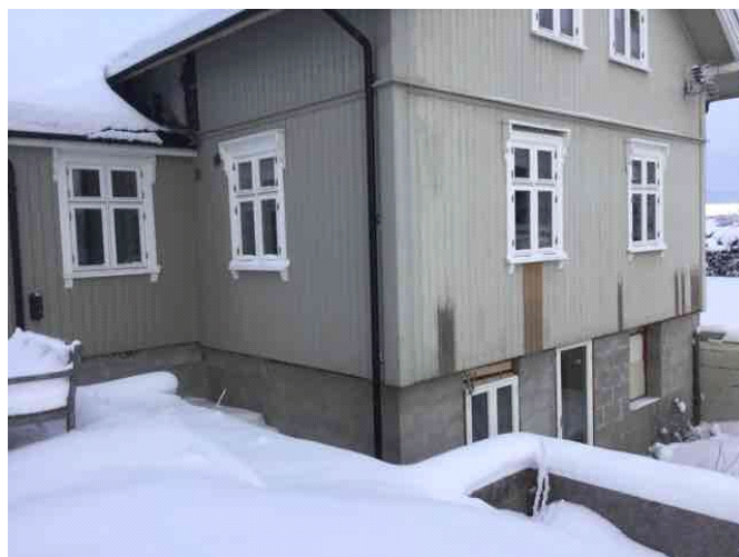
Kjeller inngang med påbegynt grunnmur mot sør
