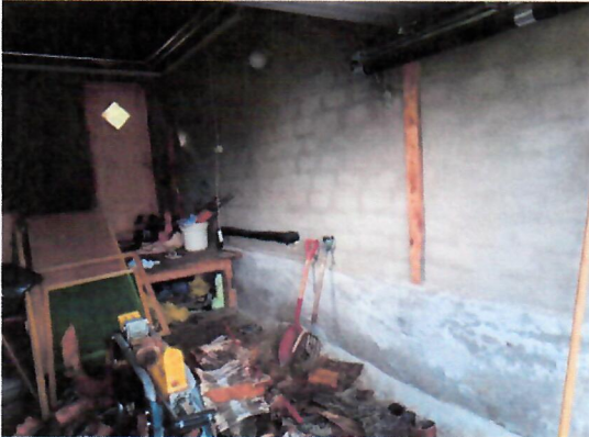
Ringmur innvendig i garasje.
