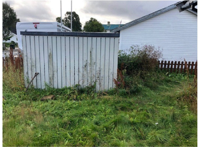
Trafo er plassert på eiendommen
