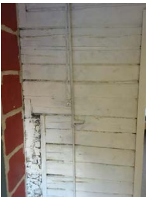
Synlig tømmer i skillevegg.
