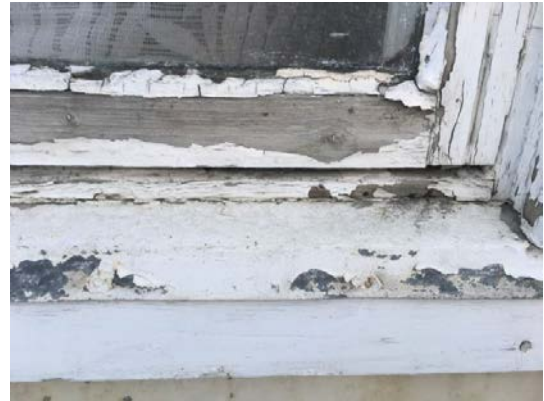
Vannbrettbeslag mot underkarm binder fukten i karmen.
