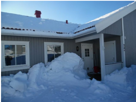
Overbygd inngang med dør til sportsbod
