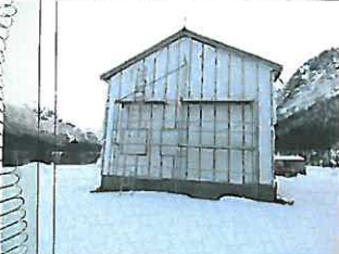
Vegg mot vest foret ut, ny vindspærre.
