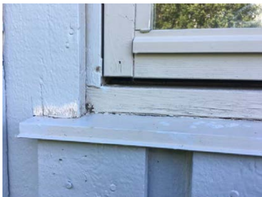
Feil montert vannbrettbeslag.
