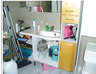
Servantskap i 1. etasje.
