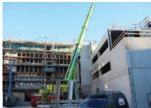
Bæresystem i betong på vei opp.
