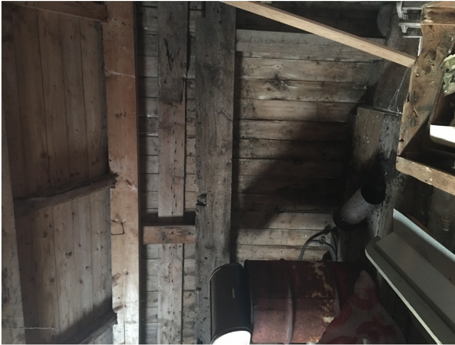
Bilde 1. Del av veggkonstruksjon, ikke innredet.
