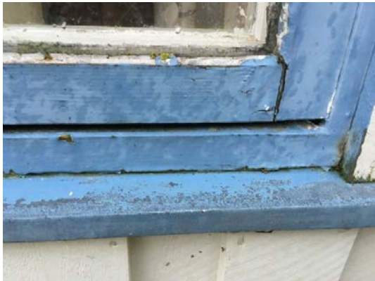
Vannbrettbeslag mot underkarm.
