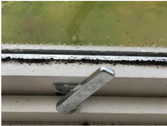
Defekt vrider og punktert glass sov 2. etg. syd
