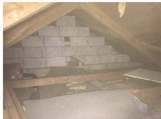
Murverk i opprinnelig del
