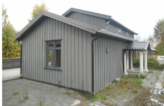
Overbygd inngang fra 2015.
