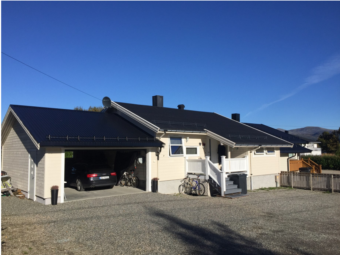
Adkomst og garasje
