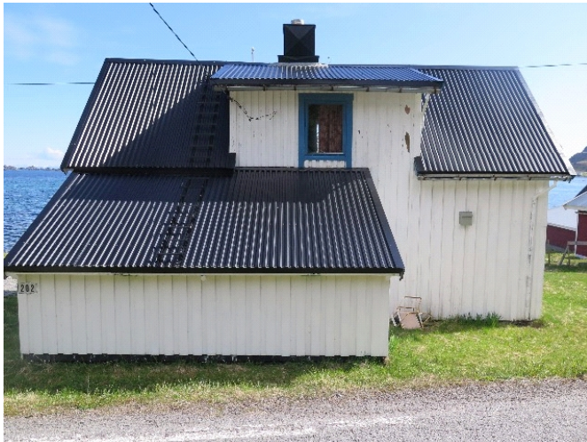
Fasade mot off. vei.
