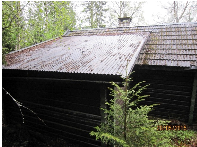
Utvendig taktekke med bølgeblekkplater
