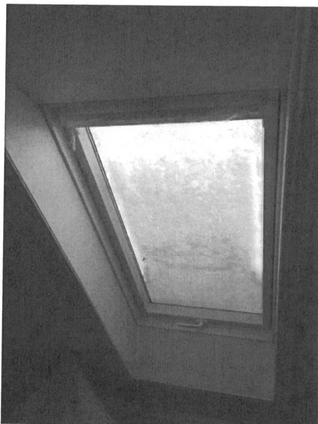
Takvindu sov loft etg.
