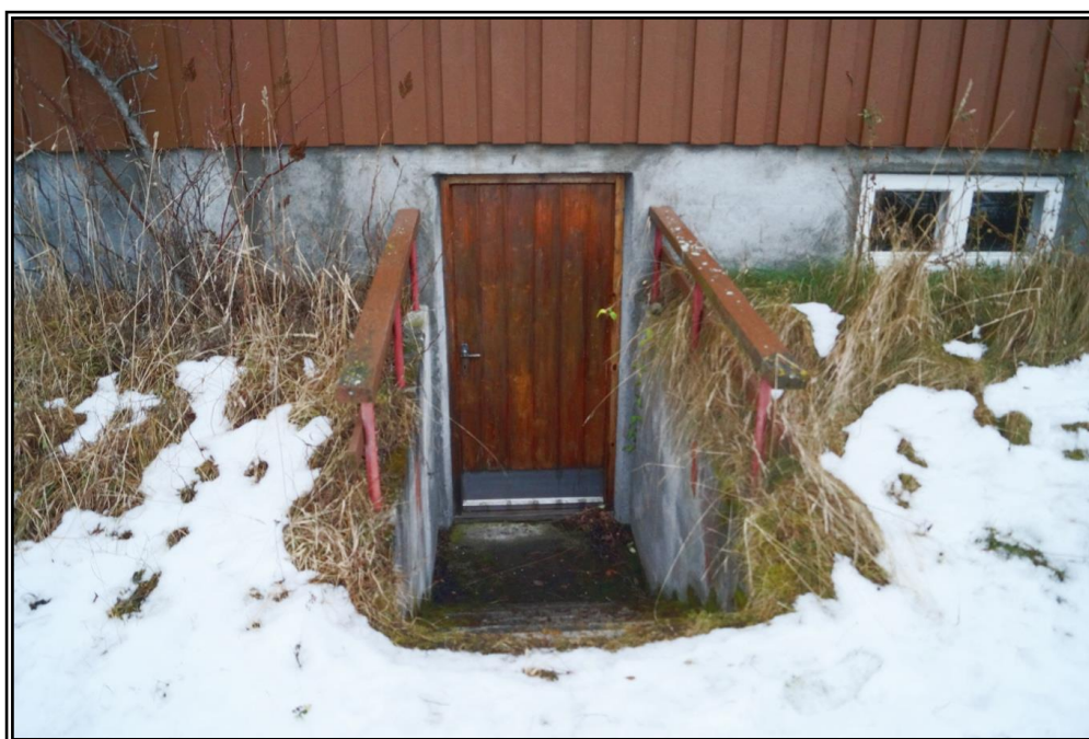
Inngangsdør til kjeller
