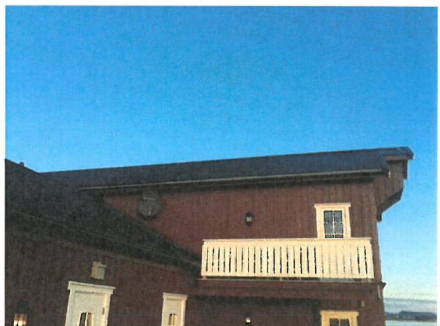
Altan og fasade mot sør-vest
