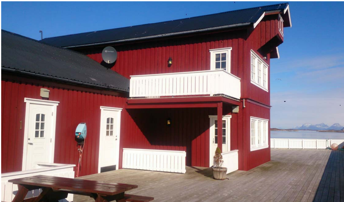
Bilde fra leilighetens terrasseandel – inngangsdør på andre siden av den utbygde delen
