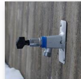
Utvendig kran (TWT02)
