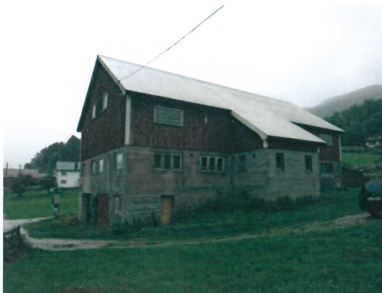
Driftsbygning, sett fra sør.
