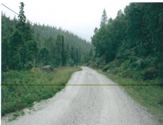
Eiendommen er medeier i Stavedalsveien som gir tilkomst til Stavedalen. Vegen er greit vedlikeholdt, men kurvatur og bratthet gjør at den ikke holder kravene til skogbilveg.
