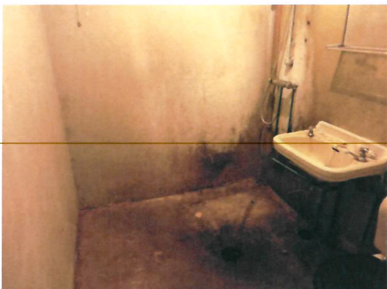
Detalj fra kjeller. Dusj servant og toalett.
