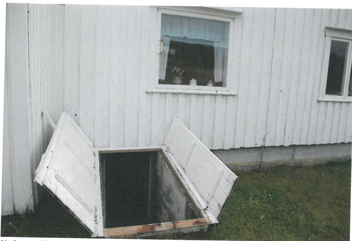
Nedgang til kjellerrom
