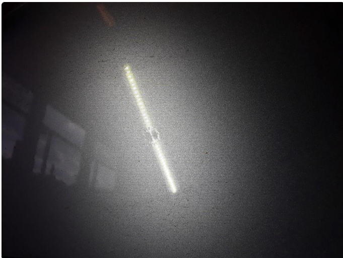
1.3 Liten steinsprut med korrosjon.
