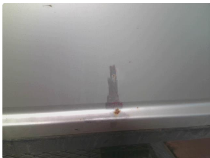
2.3 Rust/korrosjon
