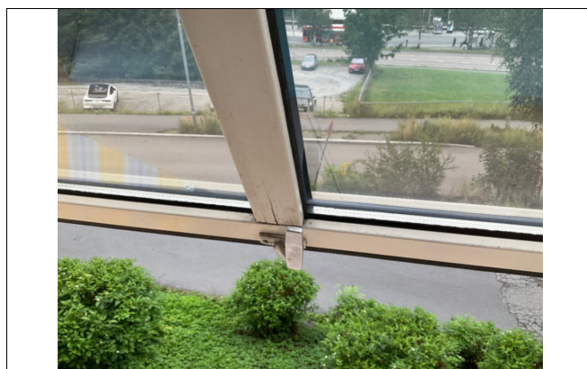
Vinduer fra byggeår.
