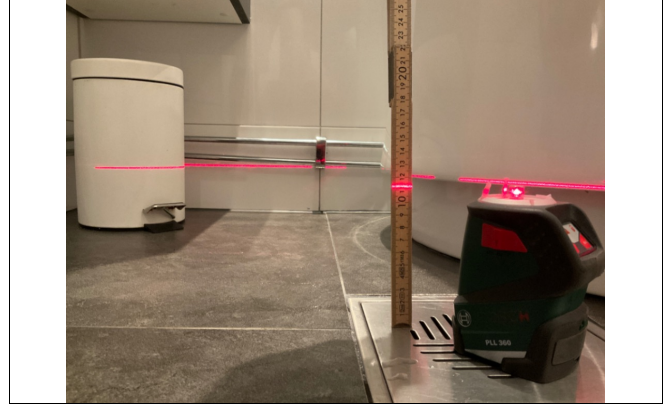
Kontroll av fall på gulv på bad.
