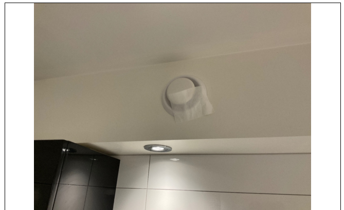
Kontroll av avtrekk på bad.
