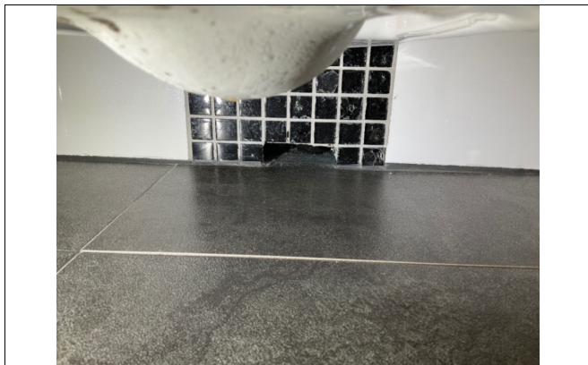
Kontroll av spalte for lekkasjevarsling ved lekkasje fra innebygget sistene.
