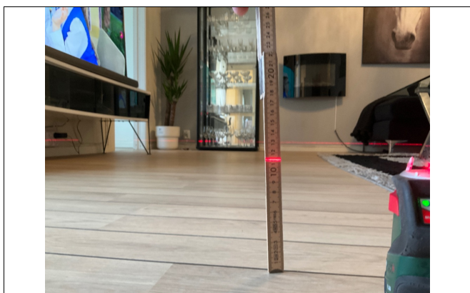
Nivellering av gulv.
