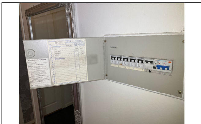
Kontroll av sikringsskap.
