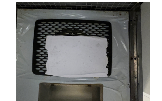
Kontroll av avtrekk på ventilator
