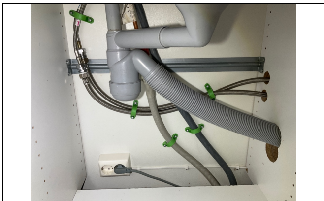
Kontroll av røropplegg i kjøkkenbenk.
