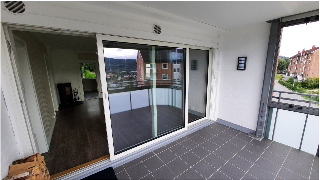
Innglasset balkong på ca. 10 m 2
