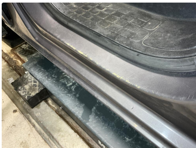
2.7 Venstre innsteg, slitt gjennom lakk
