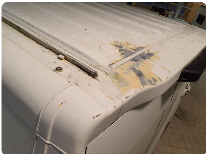
3.14 Ufagmessig utført arbeid Estimert pris.
