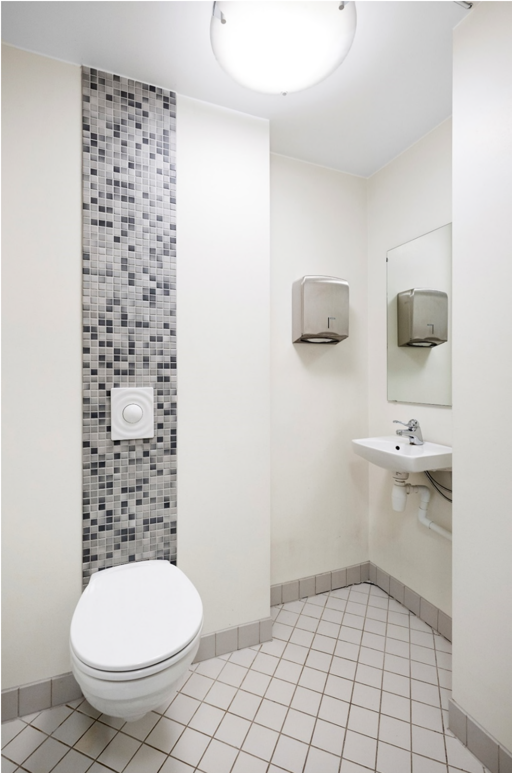
Flislagt toalettrom med vegghengt wc.
