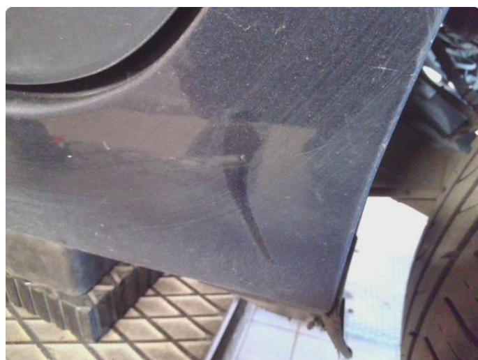
1.4 Steinsprut med rust
