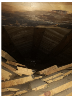
Loft sett fra innvendig luke. Konstruksjonen fremstår som tørr i dette området.
